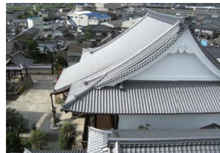
光円寺平成大改修の施工(平成22年)
