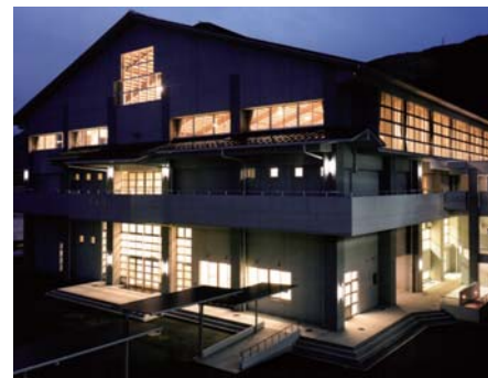
広島県立府中高等学校体育館(平成9年)
